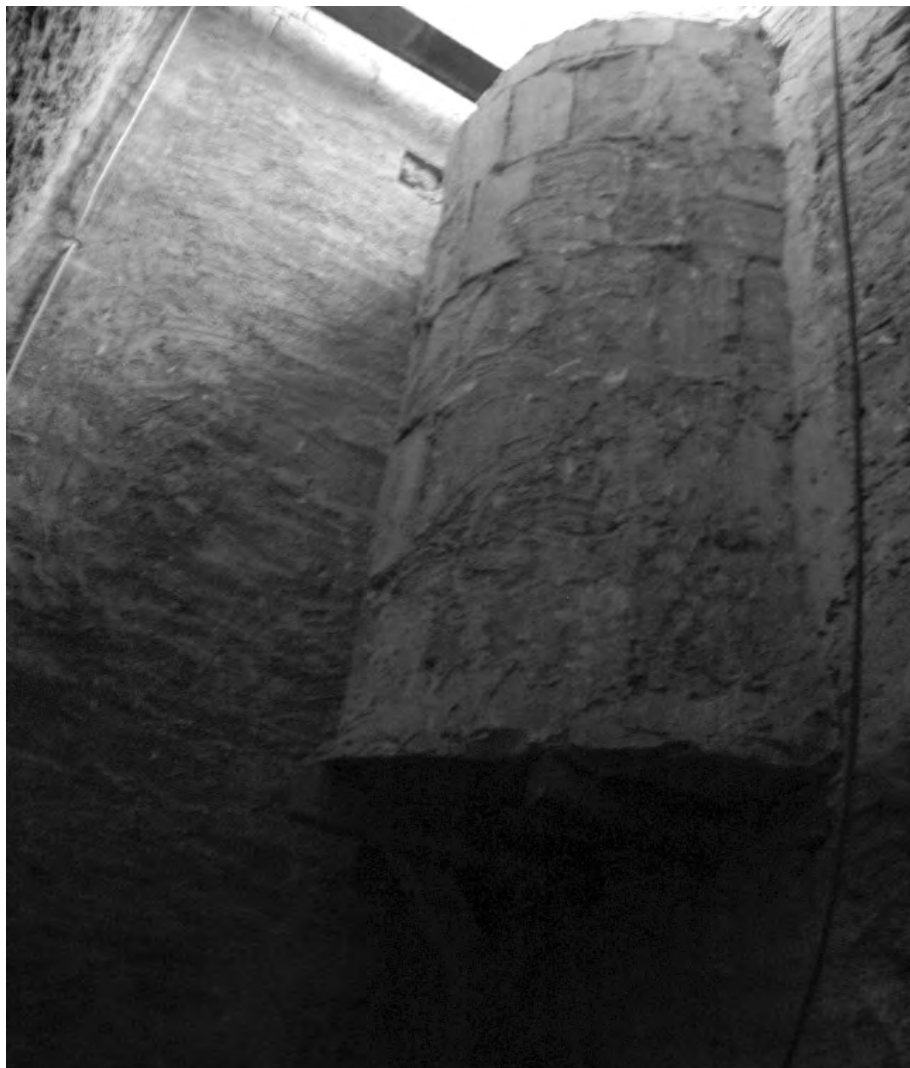
Part posterior de l'última capella de l'Epístola, ocupada pel caragol i campanar. S'observa a la dreta el mur retranquejat i la fornícula per a la imatge que es veu des de l'església, enfront la paret del caragol i a l'esquerra el mur que recau a la plaça del Santíssim.
